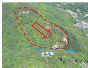
災害発生時の状況
