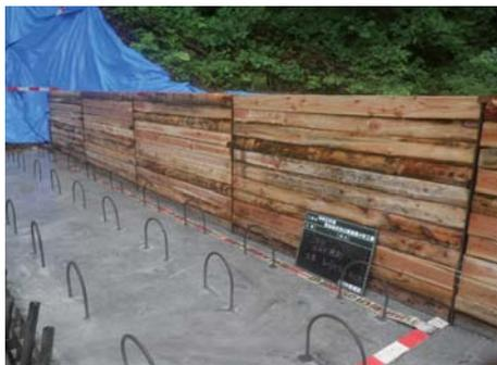
丸太残存型枠による県産材の積極的な活用
