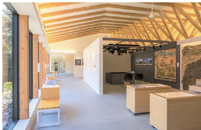
木曽地域産材(ヒノキ・カラマツ)を使用した内観 さとテラス三岳「展示スペース」
