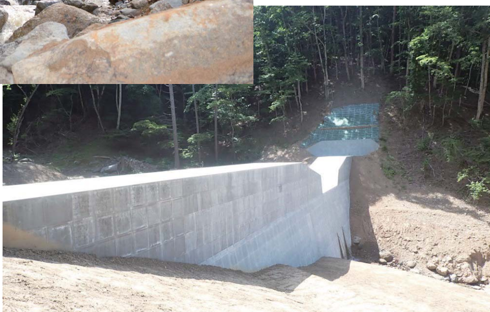
災害関連緊急治山事業 による谷止工
