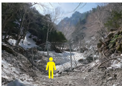
応急的な土石流対策工として強靱ワイヤーネットを設置 (上高地、地上高は約5 m)
