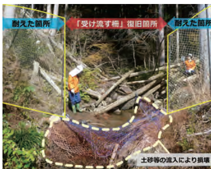
台風による被害の様子「受け流す柵」のみが損壊し周辺の柵への被害は見られない
