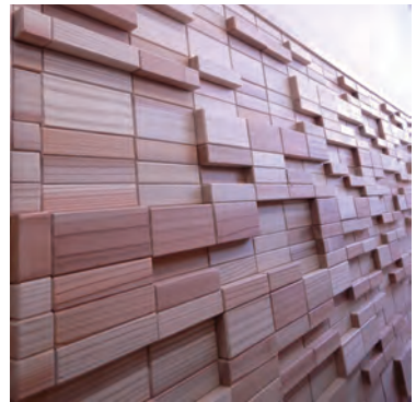
▲腰板はモザイク状に仕上げられ、おしゃれな空間づくりに活かされている。
