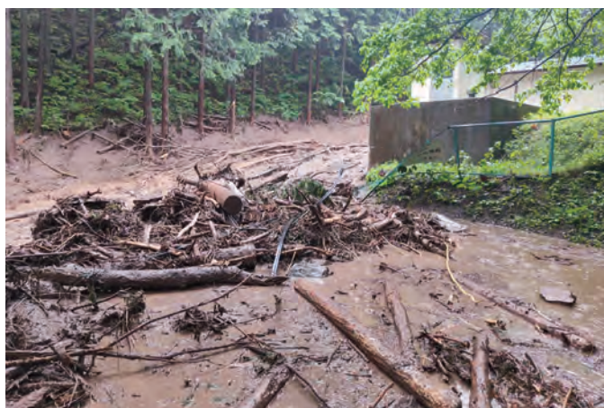
令和5年6月 下方道路へ流出した土砂・流木
