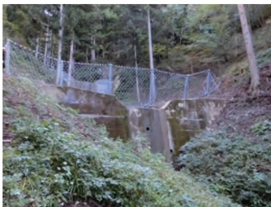
対策工事(ワイヤーネット)完了状況
