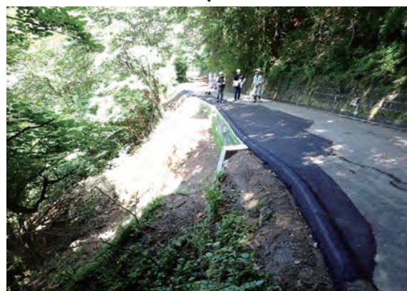
復旧後(令和8年8月)撮影
