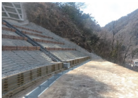
木製枠工(南木曾町袖ヶ沢)
