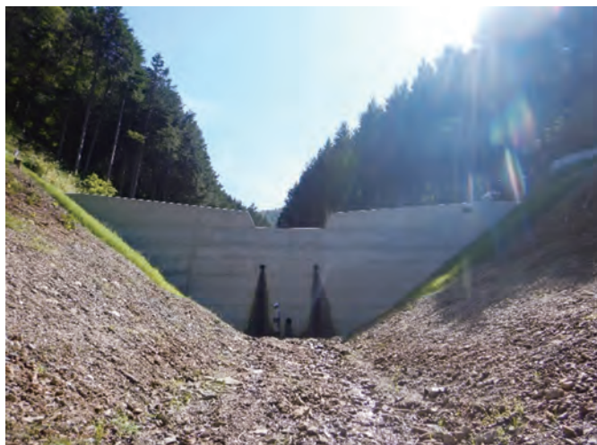
令和7年9月 溪間工完了後の様子
