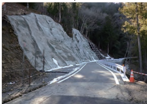
復旧後(令和8年2月)撮影
