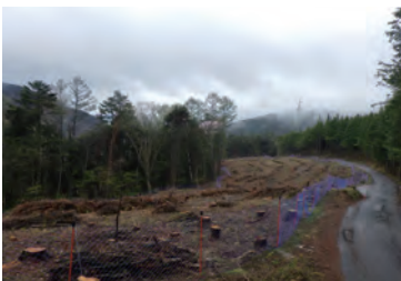
施工後の状況
